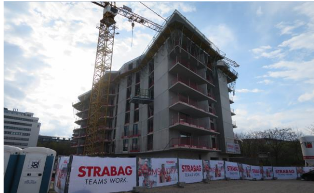
Bild re.: Rohbau Anton-Kuh-Weg 5, Quelle RVW
