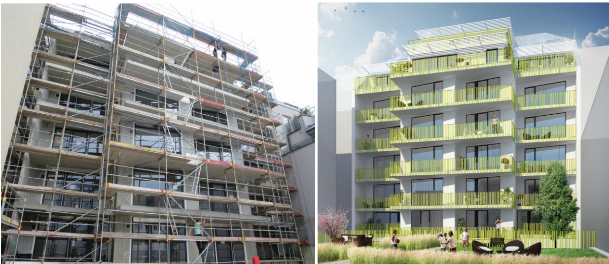
Bild rechts: Rohbau Erdbergstraße; Bild links: Visualisierung Erdbergstraße
